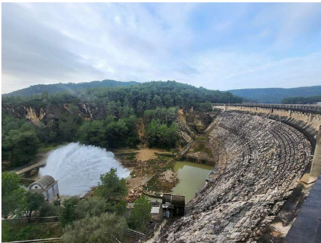
Vista panorámica de la presa de Foix. / ACA
