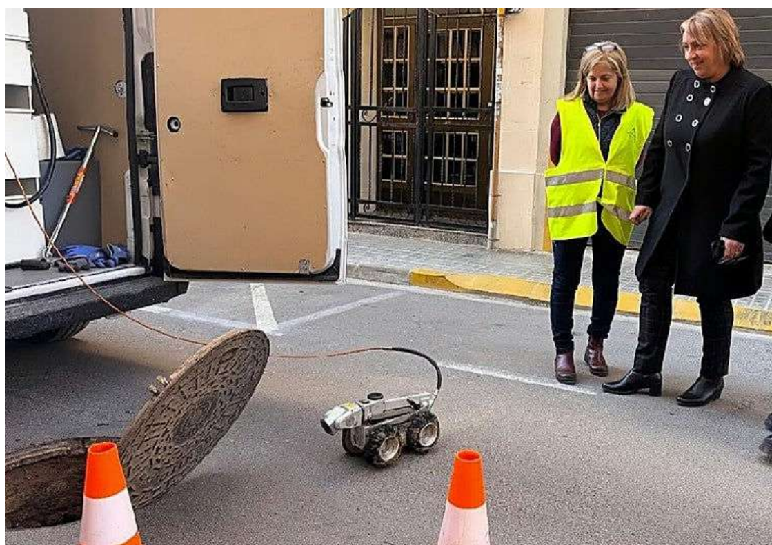
Benetússer inicia las actuaciones de reparación de su alcantarillado.
