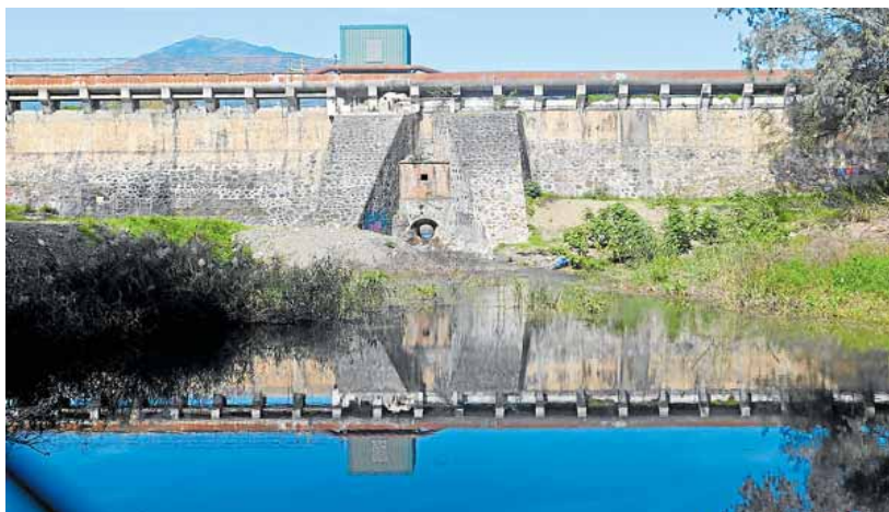
Imagen del cuerpo de presa, de 12,75 metros de altura. JOSELE
