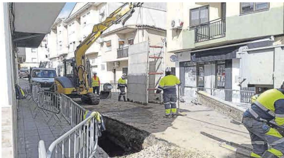
Operarios de Aquanex, en la calle Agua en Coria.
